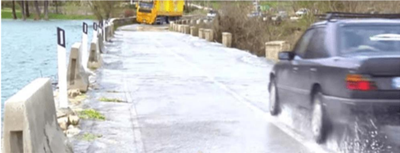
Figura 1: Niveli i ujit të Liqenit të Viroit mbi segmentin e rrugës dhe urën
